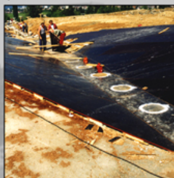
podlaha bednění na zemní skruži
