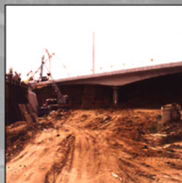
betonováno na zemní skruži
