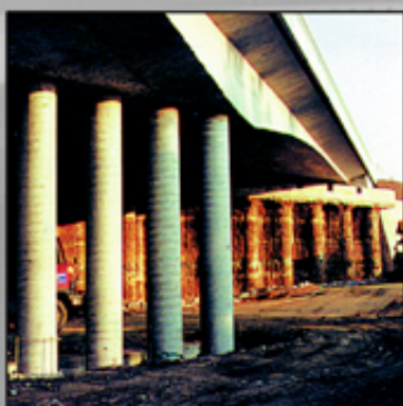
střední podpěra po odtěžení násypu
